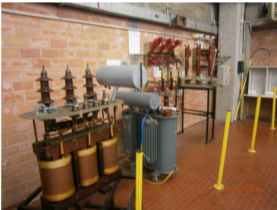
Un'immagine della sala prove in fase di costruzione nel gennaio 2016
